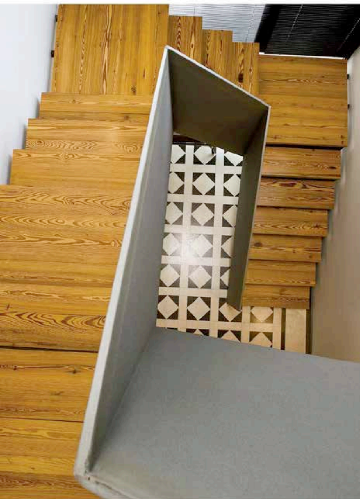
Distintos planos de la escalera que lleva a los dormitorios, hecha a nuevo con peldaños revestidos en madera y baranda de chapa plegada. El hall inferior deslumbra con sus pisos de mármol travertino turco (Eurostone).
