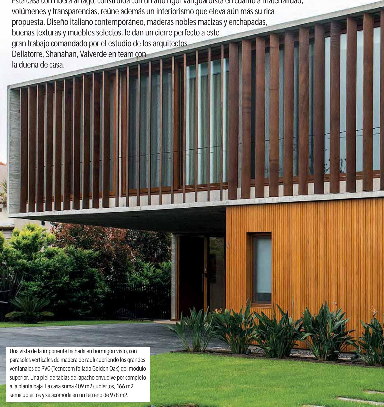
Una vista de la imponente fachada en hormigón visto, con parasoles verticales de madera de raulí cubriendo los grandes ventanales de PVC (Tecnocom foliado Golden Oak) del módulo superior. Una piel de tablas de lapacho envuelve por completo a la planta baja. La casa suma 409 m<sup>2</sup> cubiertos, 166 m<sup>2</sup> semicubiertos y se acomoda en un terreno de 978 m<sup>2</sup>.
