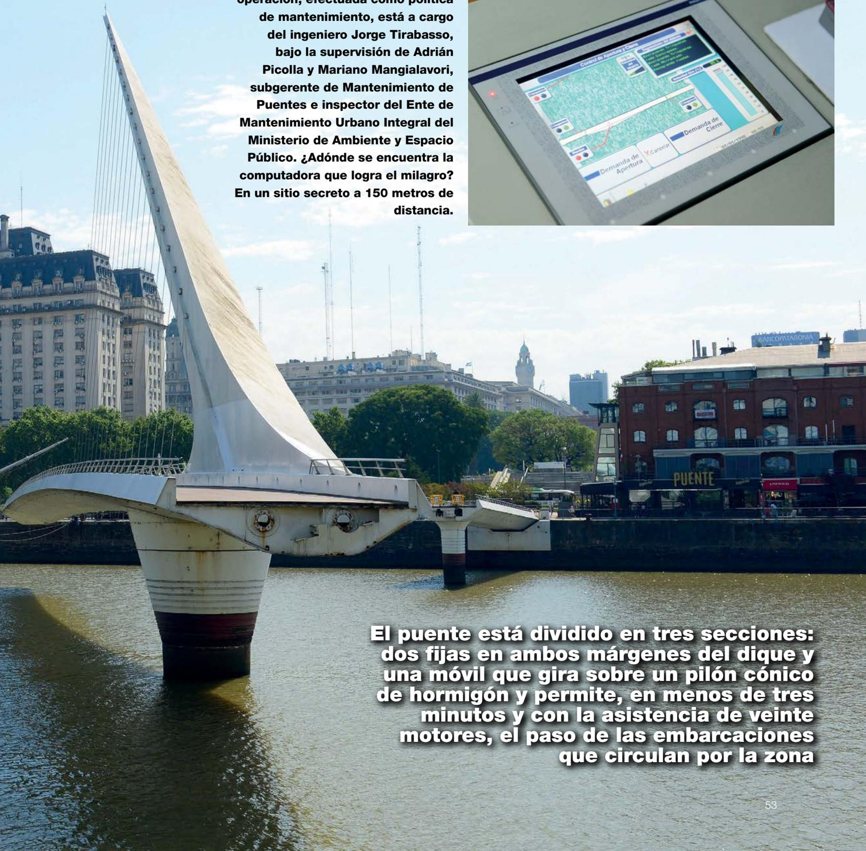
**El puente está dividido en tres secciones: dos fijas en ambos márgenes del dique y una móvil que gira sobre un pilón cónico de hormigón y permite, en menos de tres minutos y con la asistencia de veinte motores, el paso de las embarcaciones que circulan por la zona**
